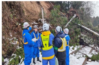
▲TEC-FORCEによる被災状況調査
