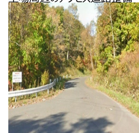
工場周辺のアクセス道路整備
