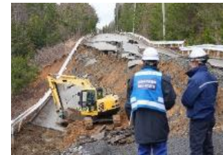
▲建設業者と連携した道路の緊急復旧
