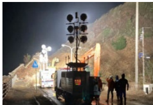
▲照明車を活用した昼夜を徹した道路の緊急復旧
